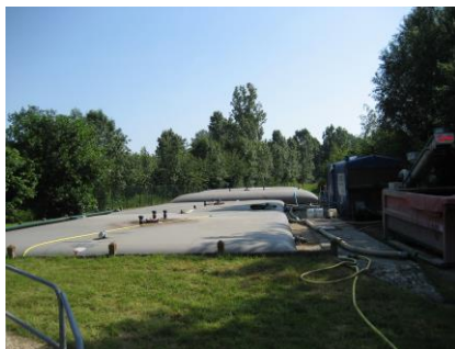
Intervention d'une UMDB sur la station d'épuration de Blandy-les-Tours
