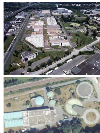
Constructeur en Seine-et-Marne : OTV
