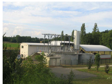
Filtration membranaire de Perthes-en-Gâtinais
